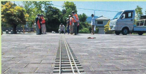
SL 機関車のレールを設置中。線路は続くよどこまでも…♪
