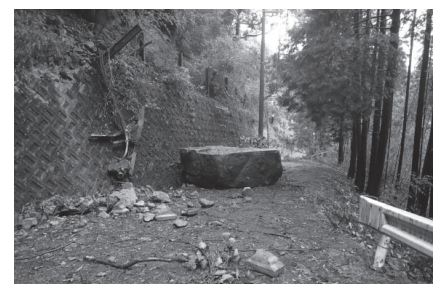
道路橋梁災害復旧事業 災害復旧費 5,023万円
