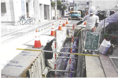
管路の更新・耐震化
