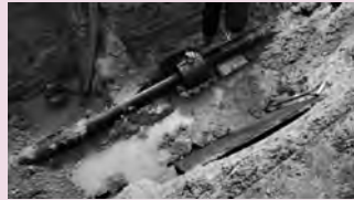
▲水道管の漏水修繕の状況
