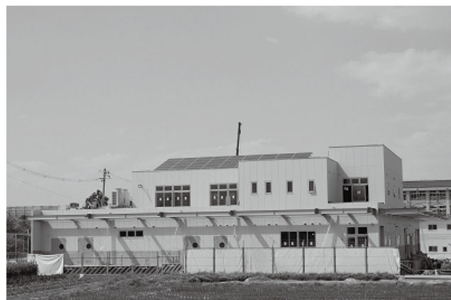
新学校給食センター建設現場
