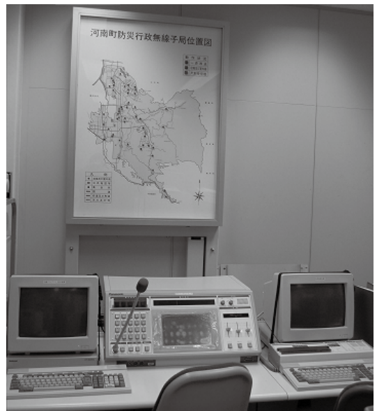
役場庁舎無線室
