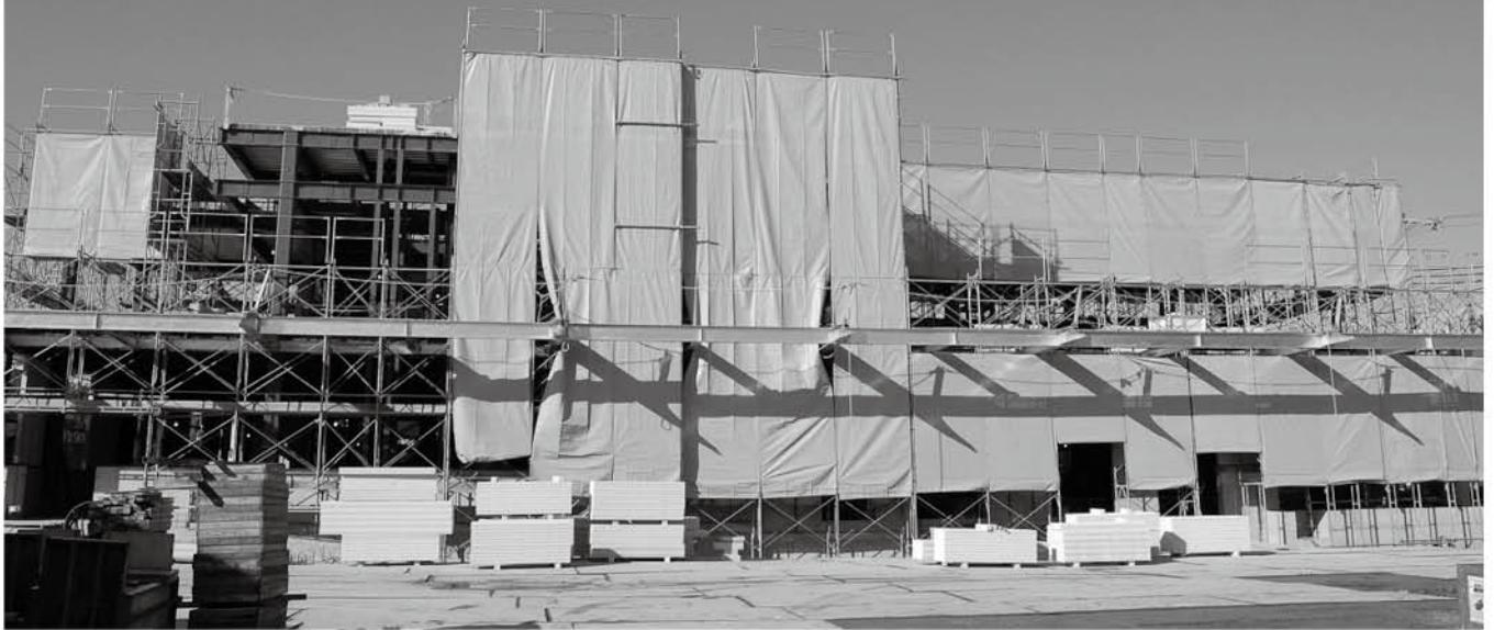
(町立中学校南側に建設中)
