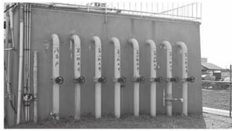
一 須 賀 浄 水 場
