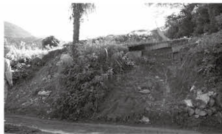
農地災害現場(青崩地区)
