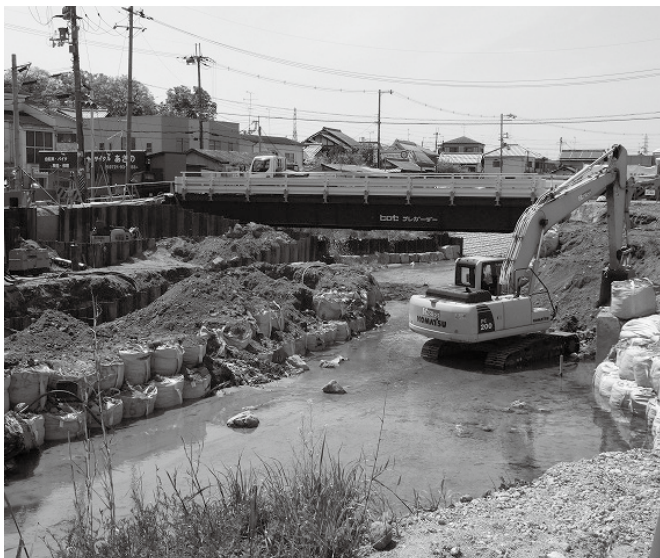
東山の中之橋の建築風景
