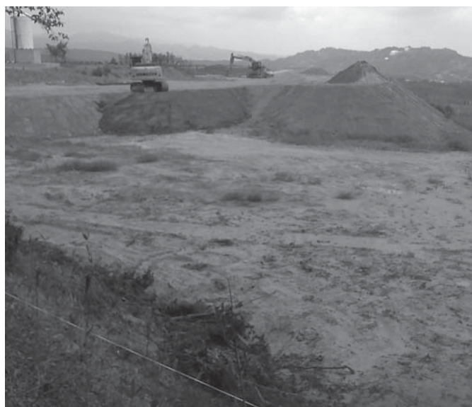
土砂埋め立て
