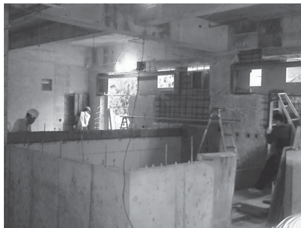
ふれあいの湯工事現場
