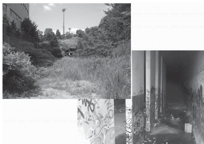
既存の山城バイパス構造物（トンネル）
