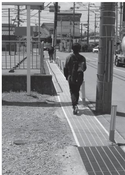
芸大前水路蓋設置
