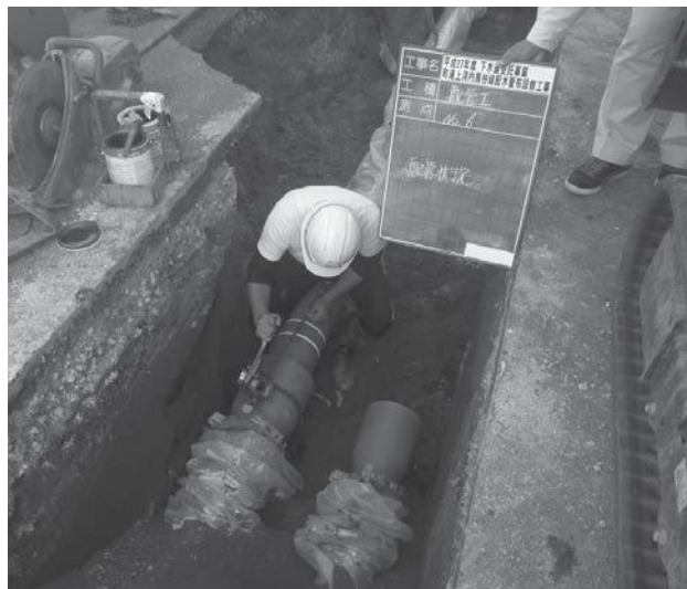
水道管工事風景
