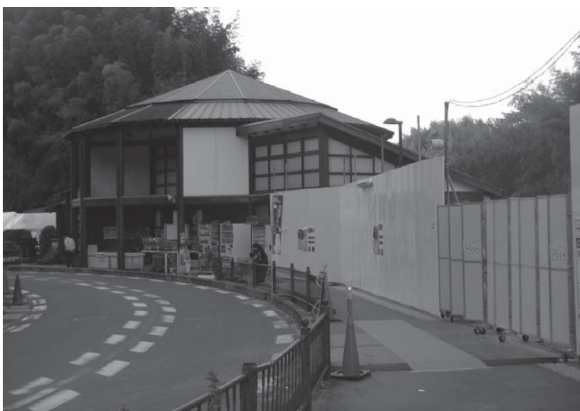
道の駅改修工事
