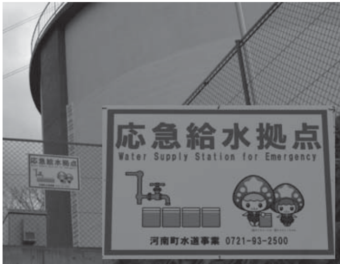
応急給水拠点
