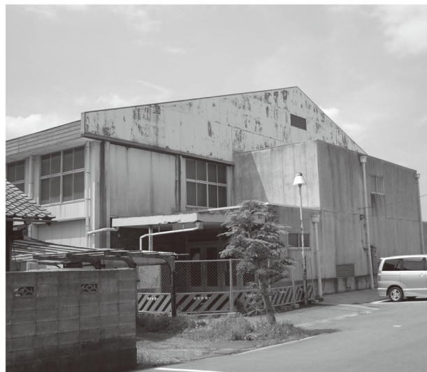
解体除去を待つ旧町民体育館
