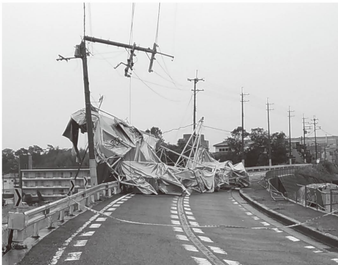
台風 21号による被害(山城バイパス)
