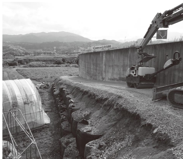
樋用線(仮設道路工事現場)
