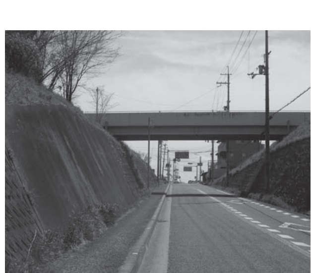
山城バイパスの歩道
