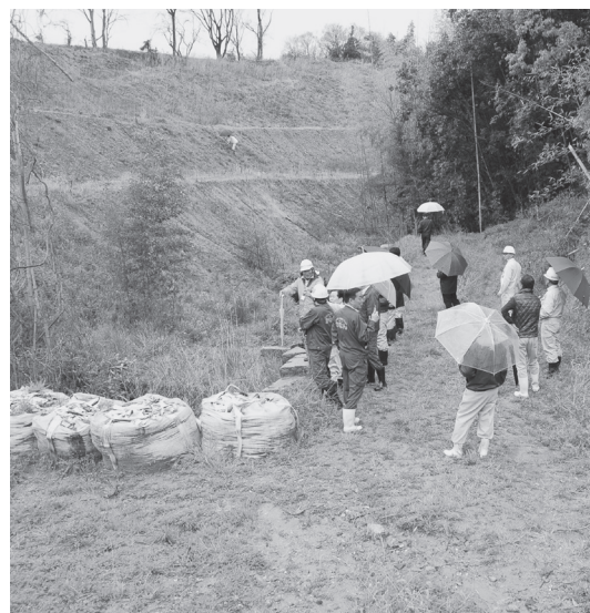
土砂の山となったままの埋め立て地 早期解決を（中地区）
