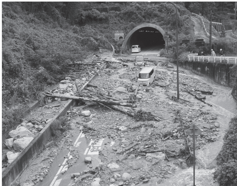
H29.10月の台風21号による被害(国道309号・青崩付近)
