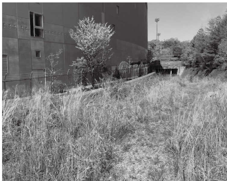
▲大阪芸術大学敷地内のボックスカルバート附近。
