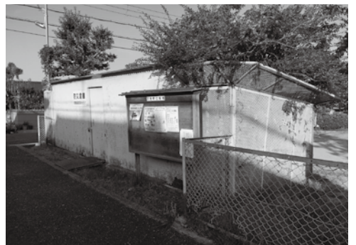
▲各自治会では、防災倉庫の設置や補修などを自費で行っている。(写真は、大宝北公園の防災倉庫。)
