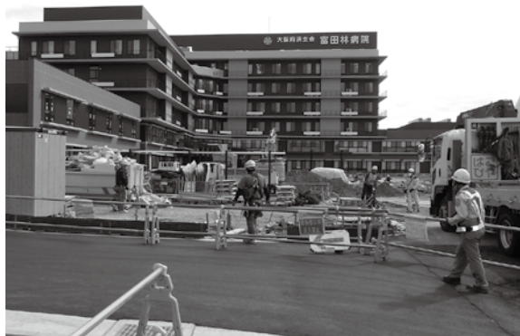
▲医療体制の充実を。(写真は、完成間近の富田林病院。)
