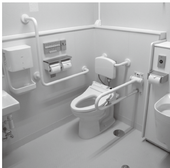
▲老朽化施設の改修は。 (写真は、洋式トイレ改修後の写真(役場庁舎内)。)
