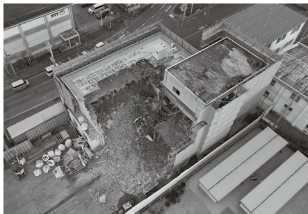
▲旧役場庁舎の解体撤去
