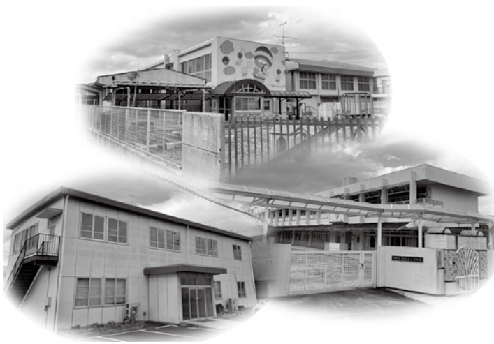
▲利用していない、限定的にしか利用していない公共施設は。 (写真は、旧かなんこども園(上)、旧中央保育園(右下)、旧庁舎別館(左下))。
