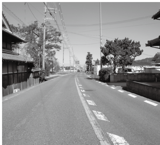
▲府道柏原駒ヶ谷千早赤阪線の歩道設置完了に向けて取り組めないのか。
