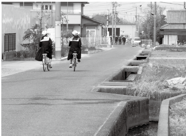
▲通学路の用水路。グレーチングや反射板の設置を。 (写真は、町道大ヶ塚今堂線。)
