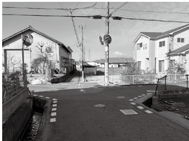
▲抜け道となる交差点で事故が多発。対策を講じられないか？
