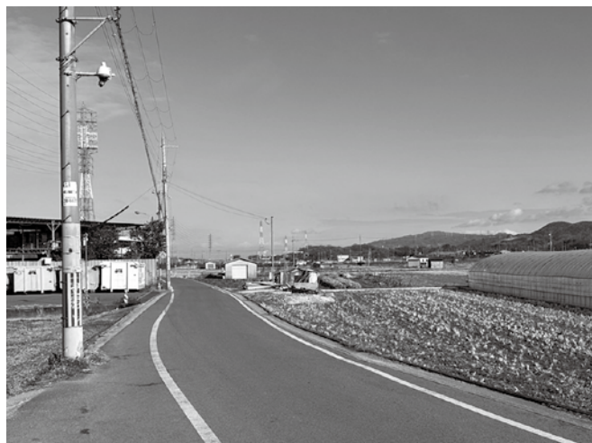
▲大型車が頻繁に通行する町道。行き来が困難な状況の対策を！
