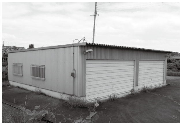
▲災害時に必要とする備蓄品や装備品など、新製品や改良品を加える考えは？ (写真は、神山地区にある町の防災資材倉庫。)
